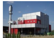
Obr. 8 Elektráreň na biomasu v Topoľčanoch (Zdroj: M. Krajčík, 2015)
